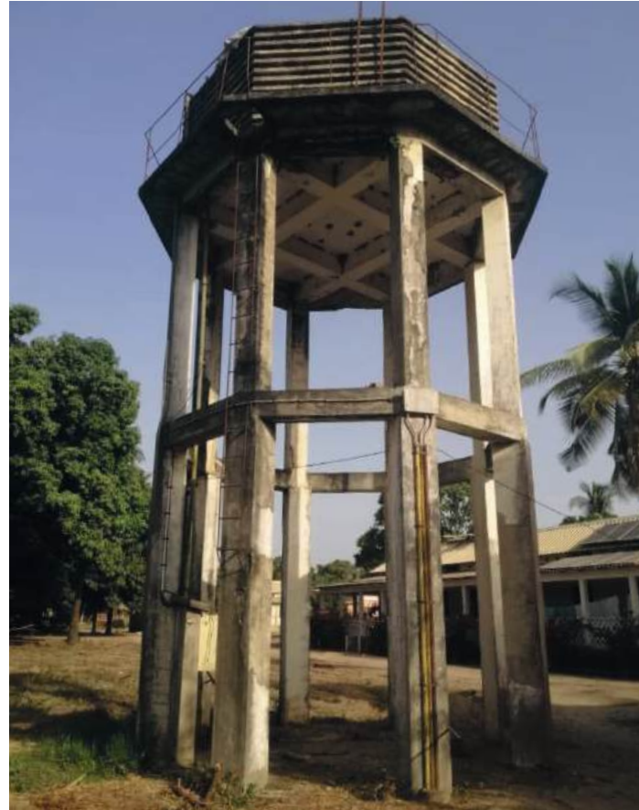
Acquedotto prima della restaurazione
